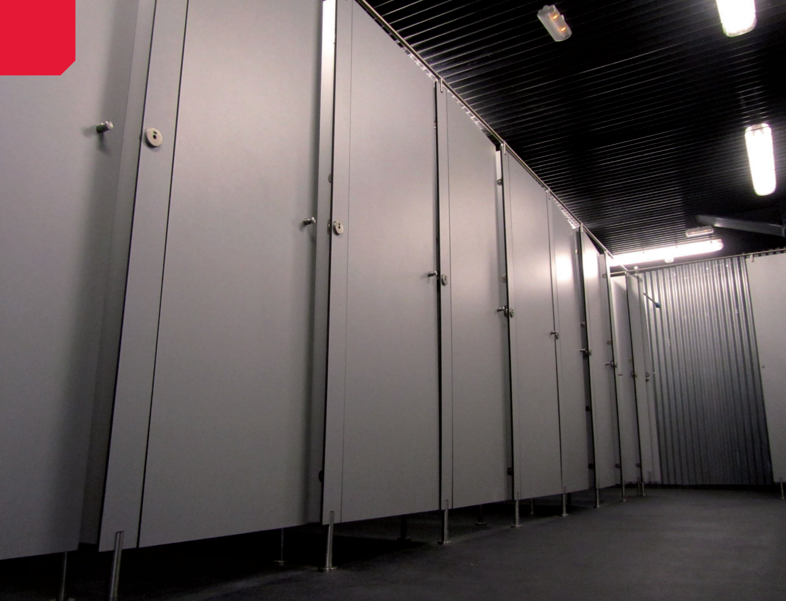
PALACIO DEPORTES BILBAO ARENA BILBAO
